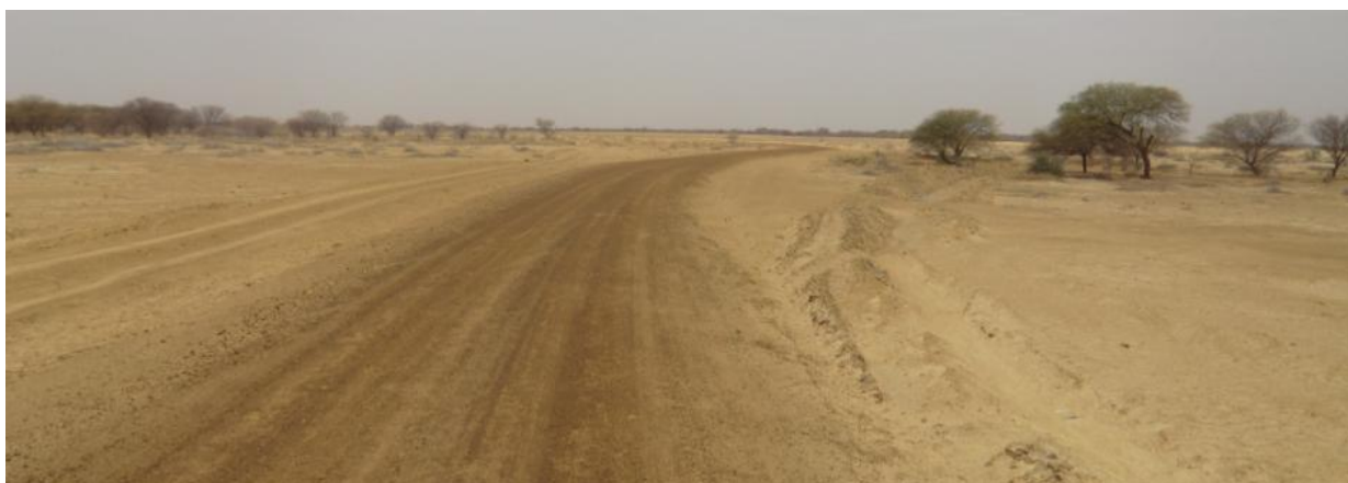
Piste de desenclavement (7 km ) towards Mblele Mbaye (Feb. 2015).
