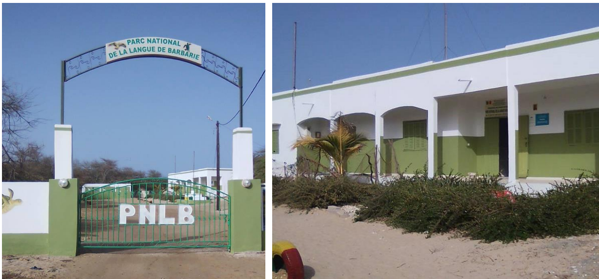
Photo 2: Vue de l'entrée du parc (gauche) et du poste de commandement (droite)
