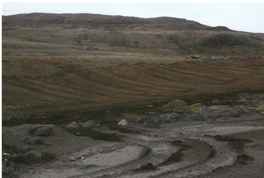
Figur 25. Opgivet kørespor (km 18,8), 28. august 2007. Sporet blev forlagt til flodsengen. Selve sporet er jævnet ud, men her er der ikke lagt grus på.
