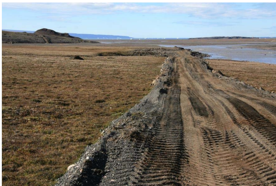
Figur 12 (to fotos). Sporet på opfyldning (oven på fiberdug og geo grid ) hen over det fugtige græsland (km 21,0), 28. august 2007.
