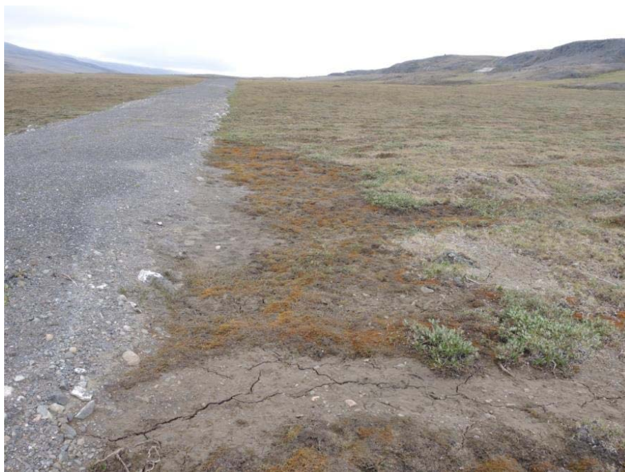
Figur 30. Tegn på opstemning af vand om foråret langs køresporet over det fugtige græsland.
