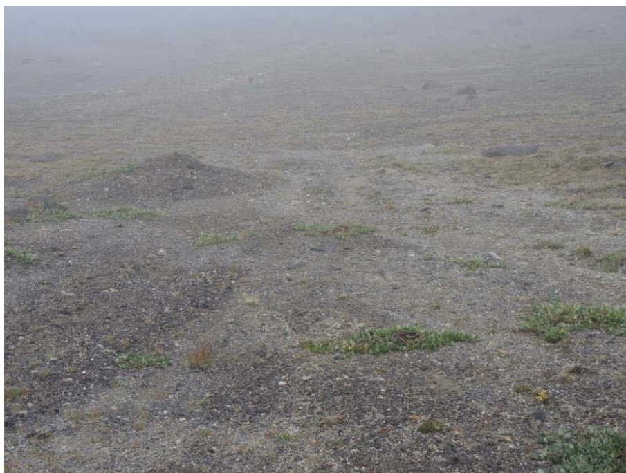
Figur 23. Skade nr. 4, 4. august 2015. Plantevækst er ved at etablere sig.
