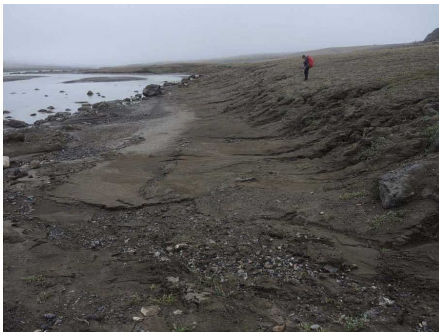
Figur 26. Samme sted som Figur 25 (set fra den anden side), 4. august 2015. Sporet er blevet planeret, skrænterne jævnet ud, men der er ikke lagt grus på spor og skrænter, og der ses vanderosion på skråningen.
