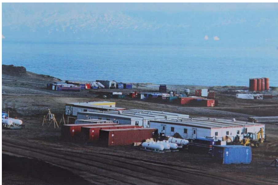
Figur 5. Base camp, storage staging area og brændstofdepot (tank farm), sommer 1996. Foto fra Well History Report (grønArctic 1996).
