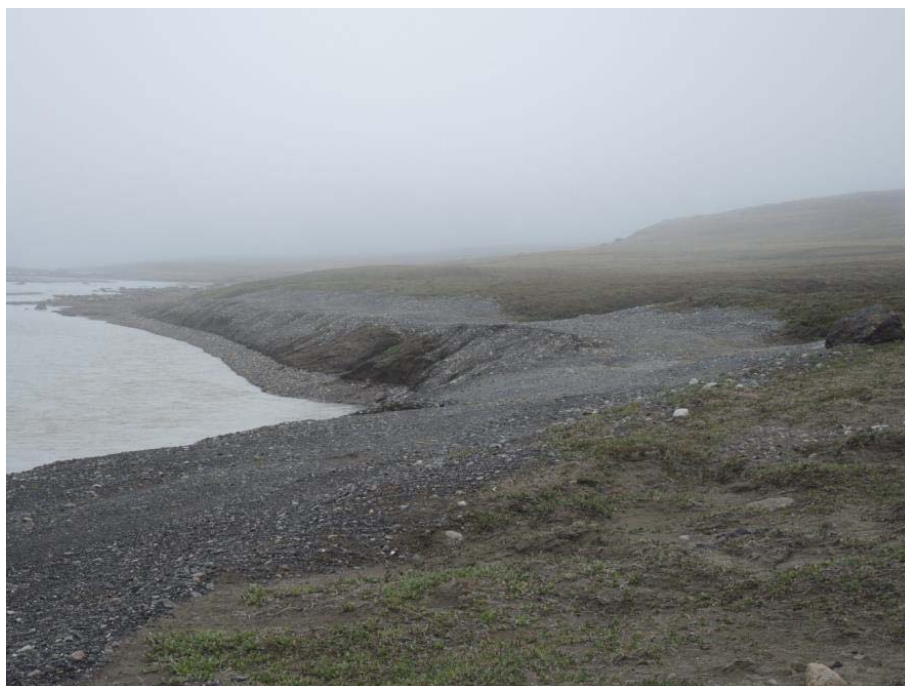
Figur 24. Samme sted som Figur 23, 4. august 2015. Sporet er blevet planeret, skrænterne jævnet ud og der er lagt grus på spor og skrænter.
