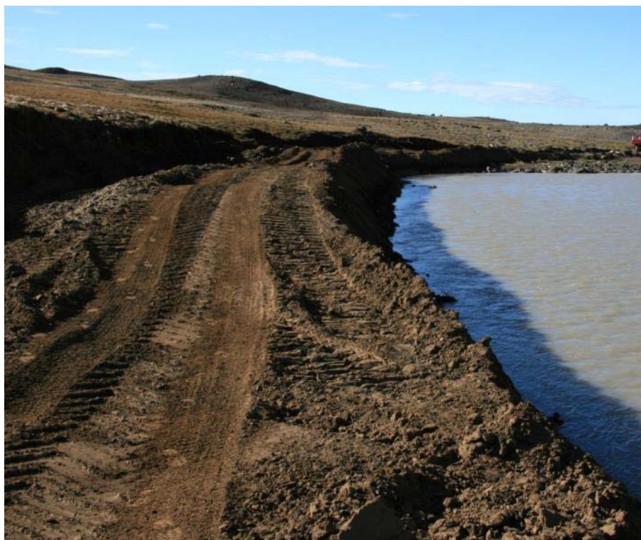
Figur 19. Opgivet kørespor (km 19,9), 28. august 2007. Sporet blev for blødt pga. optøet permafrost, og det blev forlagt til flodsengen.
