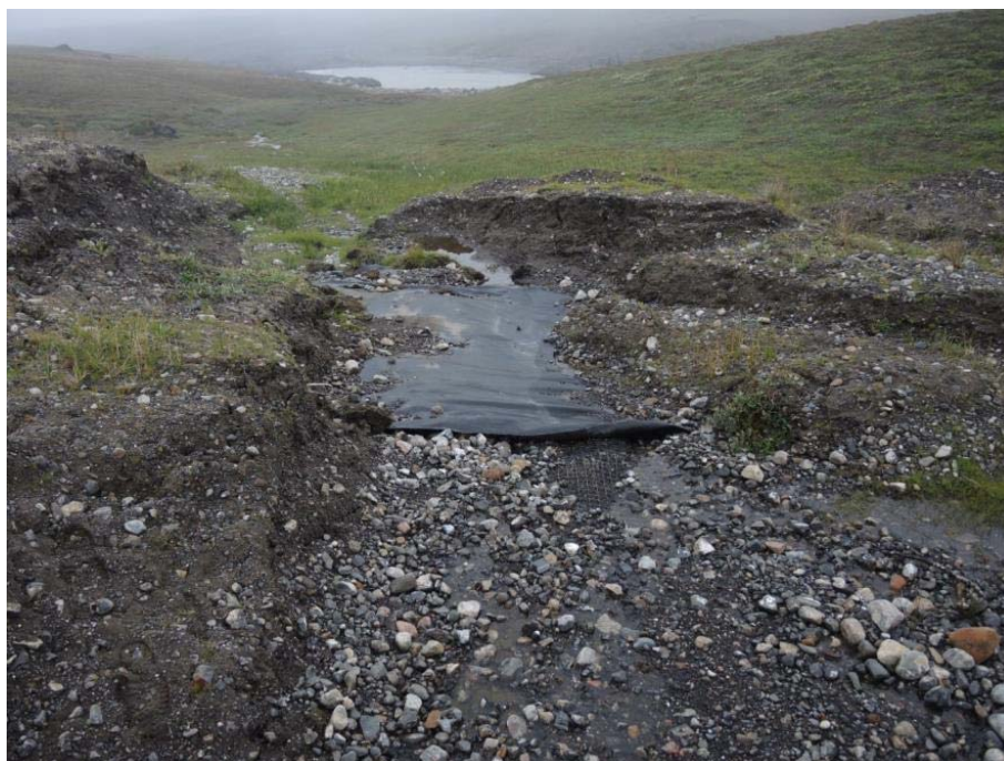
Figur 18. Overførslen ved km 20,0. Røret er fjernet, men fiberdug og geo grid ligger stadig på stedet, 4. august 2015.
