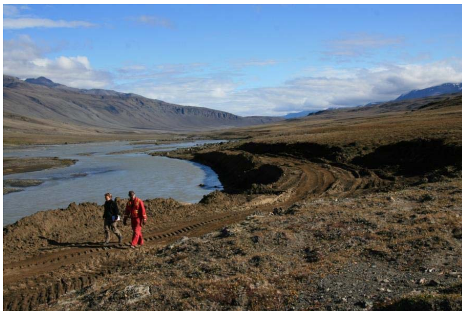
Figur 23. Opgivet kørespor (km 19,9), 28. august 2007. Sporet blev forblødt pga. optøet permafrost, og det blev forlagt til flodsengen.
