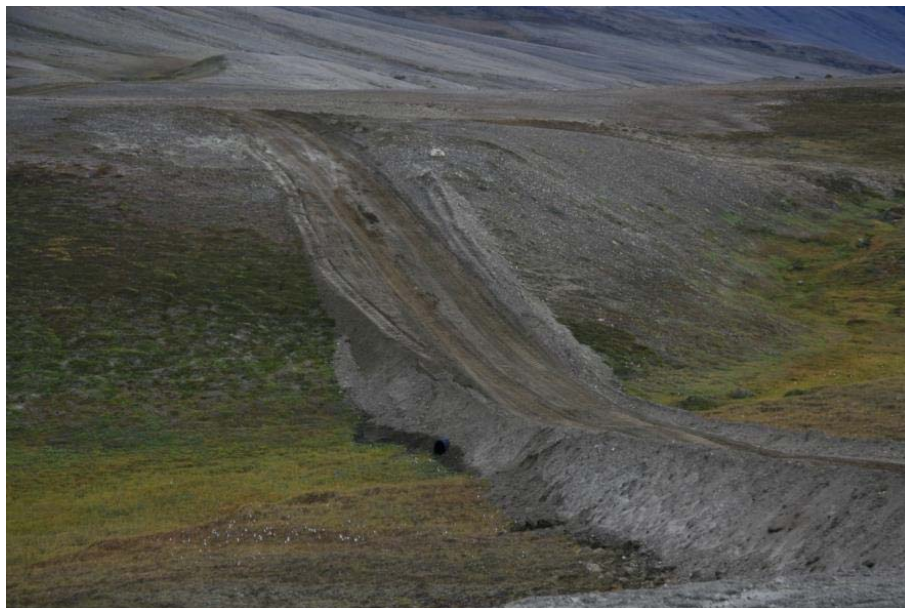
Figur 14. Sporet på opfyldning i lavning (km 20,0) med rør til vandløb i bunden, 28. august 2007.
