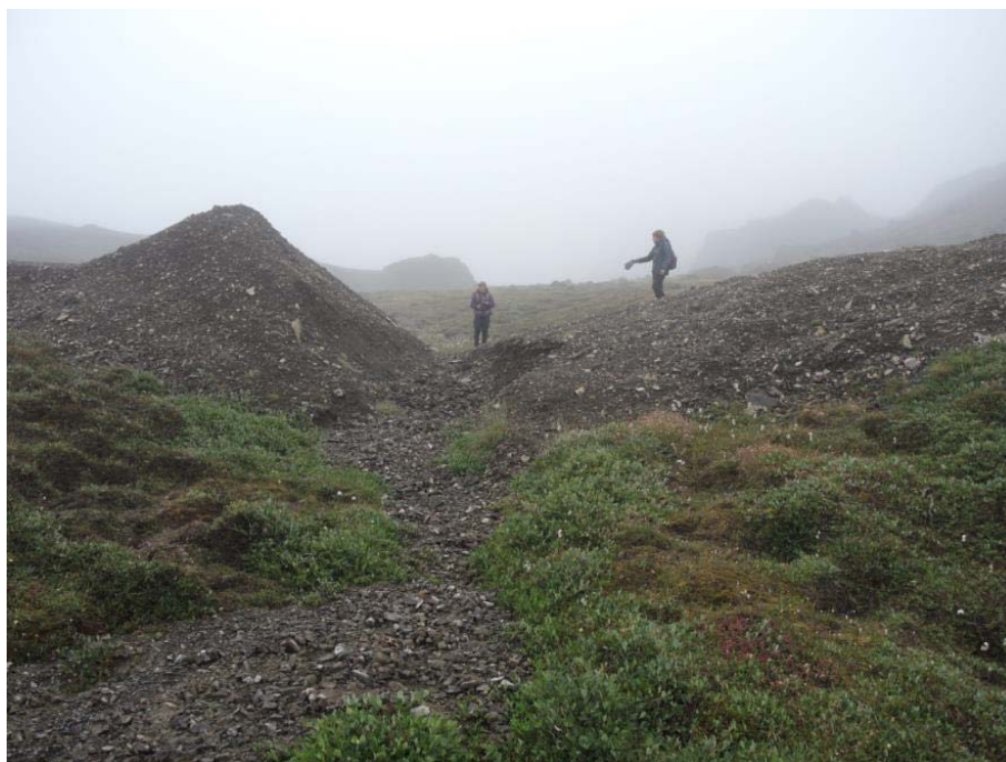
Figur 31. Det andet sted, hvor fyldet over et underføringsrør er lagt op i en bunke.
