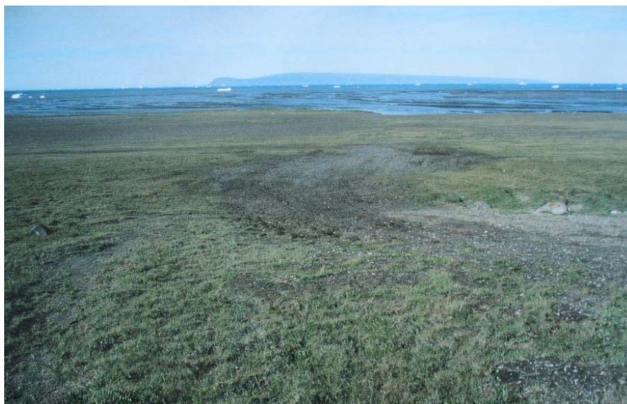
Figur 2 (to fotos). Skade nr. 1, 15. juli 1998. Alle ujævnheder er planeret, og der er fyldt grus i fordybninger.
