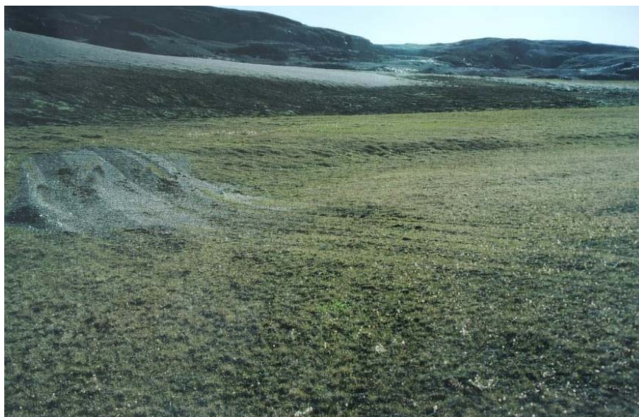
Figur 6 (to fotos). Skade nr. 2, 15. juli 1998. Der er fyldt grus i de dybe spor og derpå jævnet nogenlunde ud.
