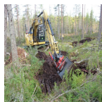
Restoration of hydrology: Excavator filling ditch ( Länsstyrelsen Västernorrland, 02-10-2013 )
